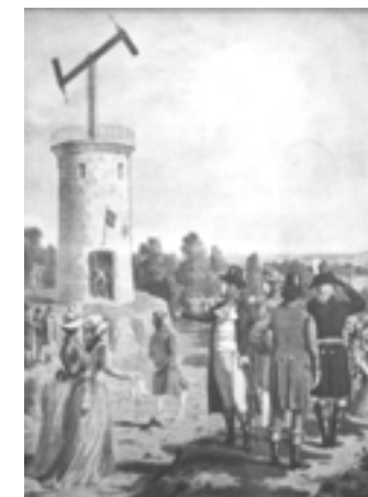
Telégrafo óptico de Chappe.
